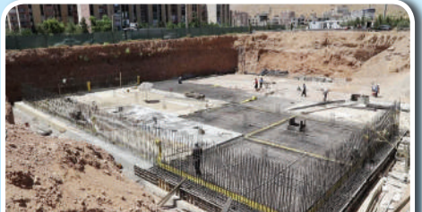
پروژه ۵۰۰۰ متر مکعبی آبیاری فضای سبز
