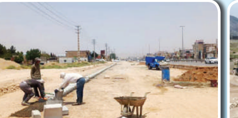
پروژه کندرو ضلع شمال محور گویم
