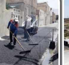
پروژه ساخت آشیانه ایستگاه آتش نشانی شماره ۸ شهرک استقلال
